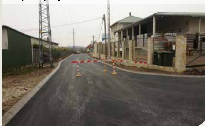
Az ipartelep aszfaltozása
